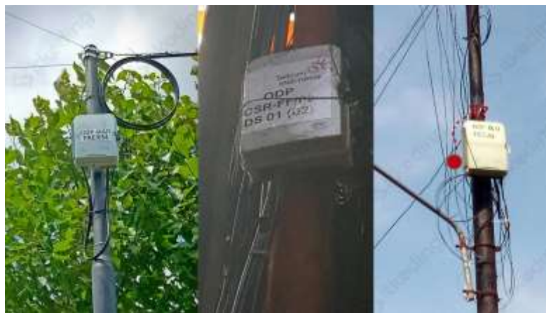
Gambar 2 Box ODP IndiHome Telkom Telah Terpasang di Desa Sangkanjoyo
